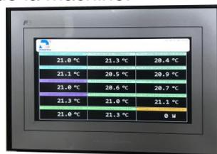
Un régulateur de température frigorifique gère le fonctionnement du groupe, la régulation de la température de la chambre froide et les phases de dégivrage
